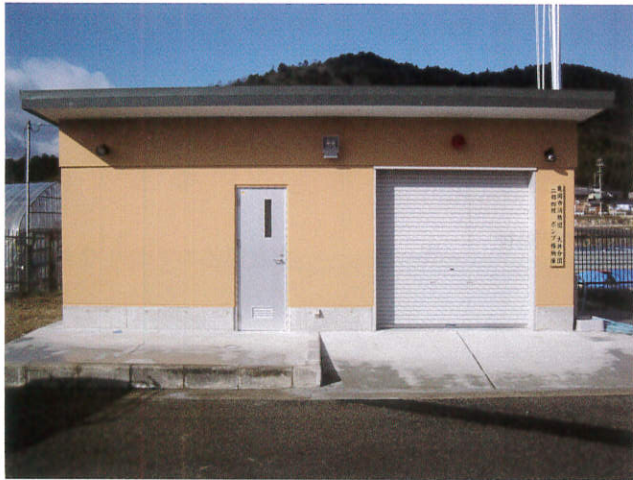
大井分団2部4班の屯所新築移転 令和3年3月
